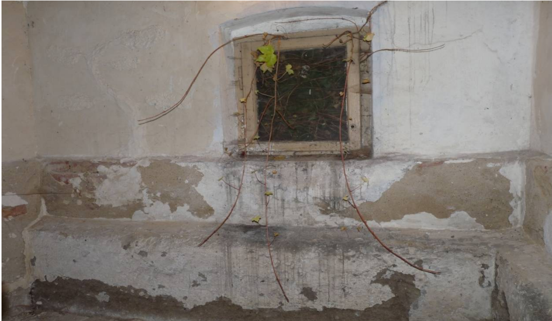
Zdj. 1 Widok posadowienia części podpiwnicznej
