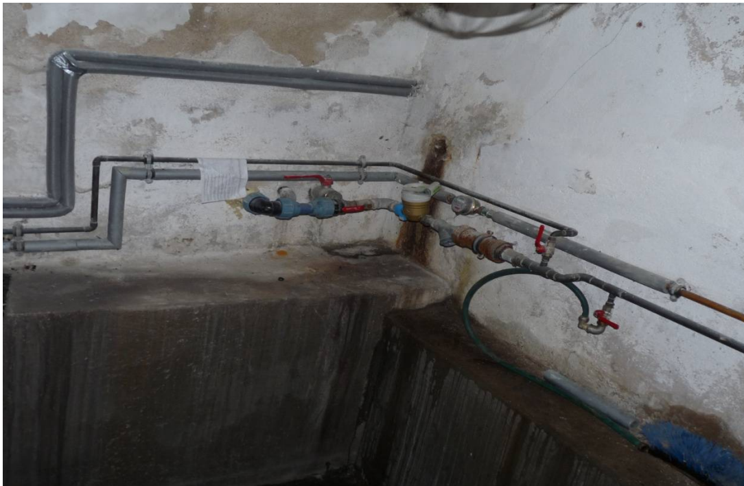
Zdj. 2 Widok naprawy(wzmocnienia) fundamentów i przeciek przez pozostawiony otwór
