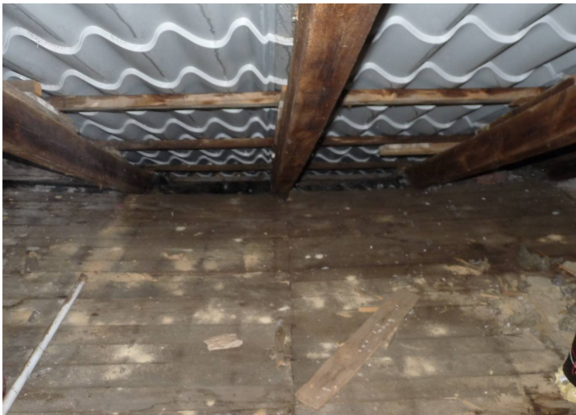
Zdj. 10 Widoczne żółte plamki wejścia szkodników drewnianych, smugi na wybrzuszeniach spływająca rosa, na drugim planie zawilgocenie desek
