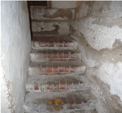
Zdj. 15 Zejście do piwnicy
