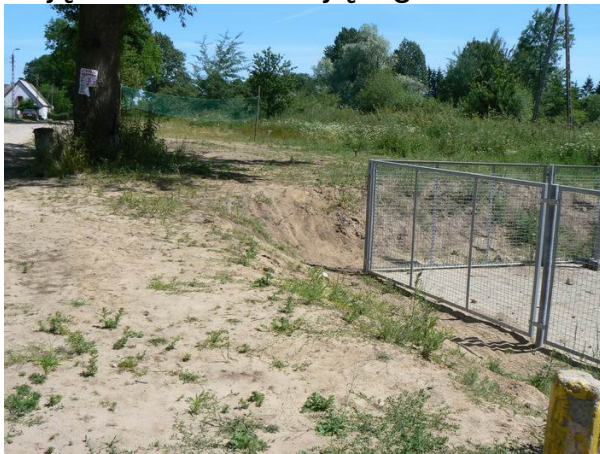
Widok od strony zachodniej
