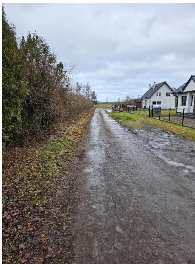
Rys nr 3 Istniejąca nawierzchnia w miejscowości Czernin
