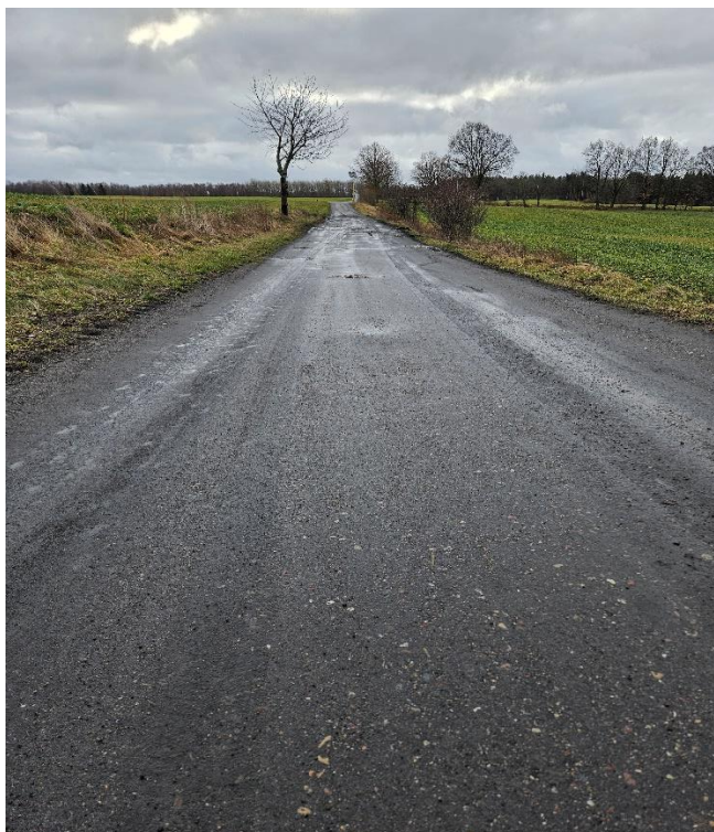
Rys. nr 2 Istniejąca nawierzchnia w miejscowości Bardy
