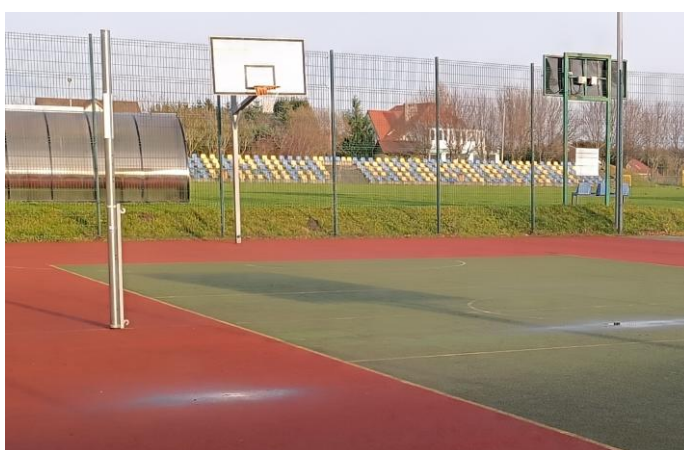
t.2. Widok na uszkodzenia warstwy nawierzchni boiska wielofunkcyjnego i z trawy syntetycznej./ fot. Dzięki uprzejmości UG. Dygowo
