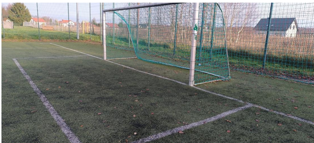
Fot.5. Widok na zużytą nawierzchnię trawy syntetycznej / fot. Dzięki uprzejmości UG. Dygowo
