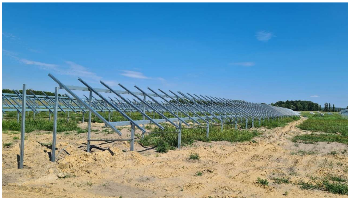
Zdjęcie 17. Przygotowane stelaże do montażu paneli – etap budowy (zdjęcie wykonane przez autora prognozy)
