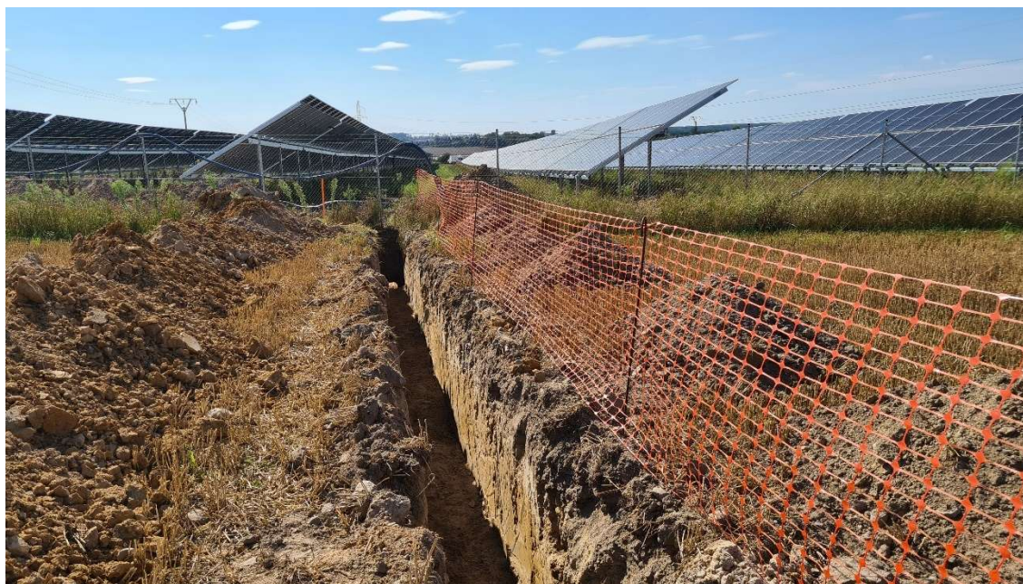
Zdjęcie 19. Wykop pod linie kablowe (zdjęcie wykonane przez autora prognozy)
