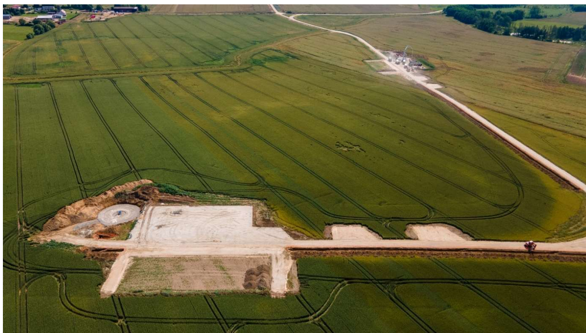
Zdjęcie 16. Droga dojazdowa oraz plac montażowy/techniczny wykonywane na potrzeby elektrowni wiatrowej – etap budowy (zdjęcie wykonane z drona przez autora prognozy)
