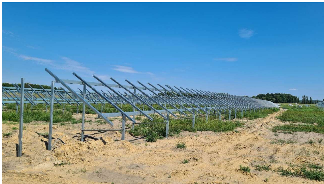
Zdjęcie 11. Przygotowane stelaże do montażu paneli – etap budowy (zdjęcie wykonane przez autora prognozy)
