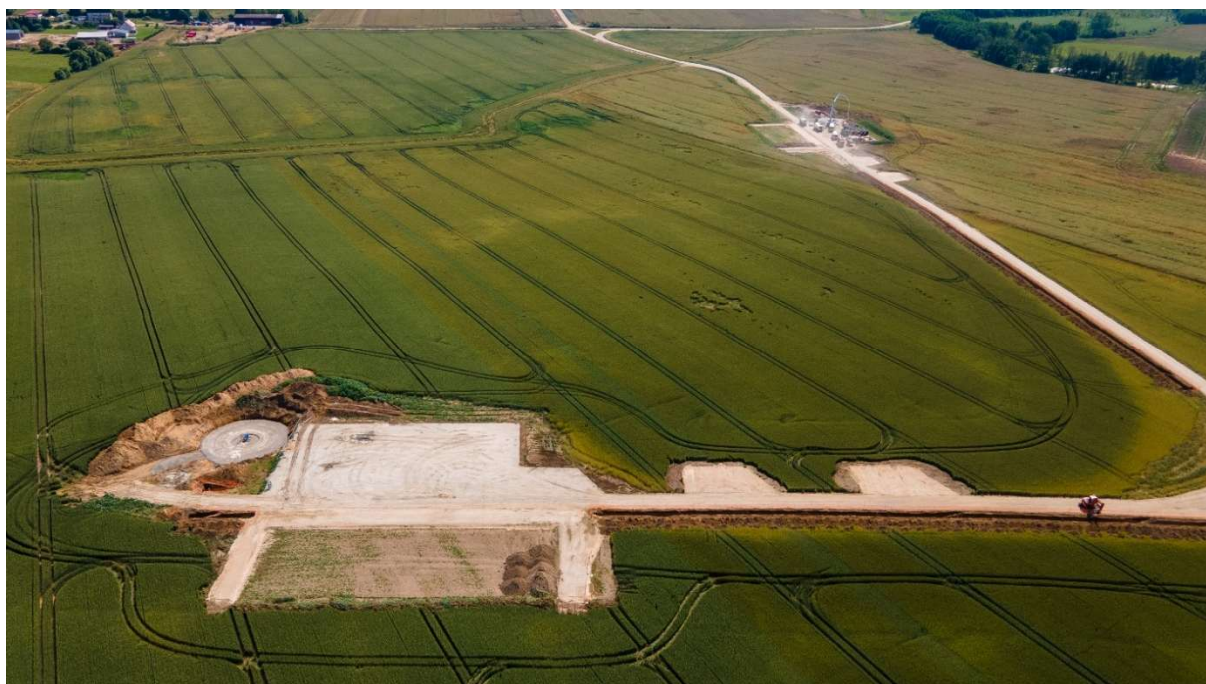
Zdjęcie 10. Droga dojazdowa oraz plac montażowy/techniczny wykonywane na potrzeby elektrowni wiatrowej – etap budowy (zdjęcie wykonane z drona przez autora prognozy)
