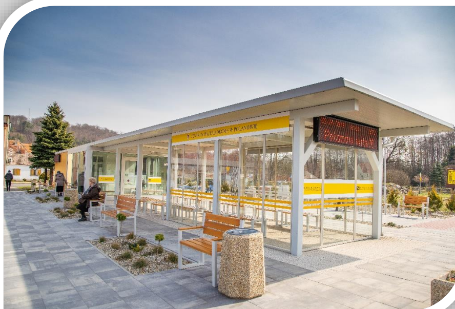
Fotografia 9. Centrum przesiadkowe w Polanowie
