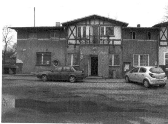
zdj. nr 1 Widok elewacji frontowej od strony drogi powiatowej
