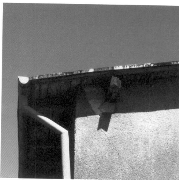
zdj. 9 uszkodzona namurnica i zarysowanie muru
