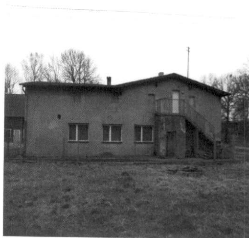
zdj. nr 2 . widok elewacji od strony drogi gminnej
