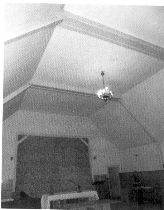
Zdj. 7 widok konstrukcji podporowej
