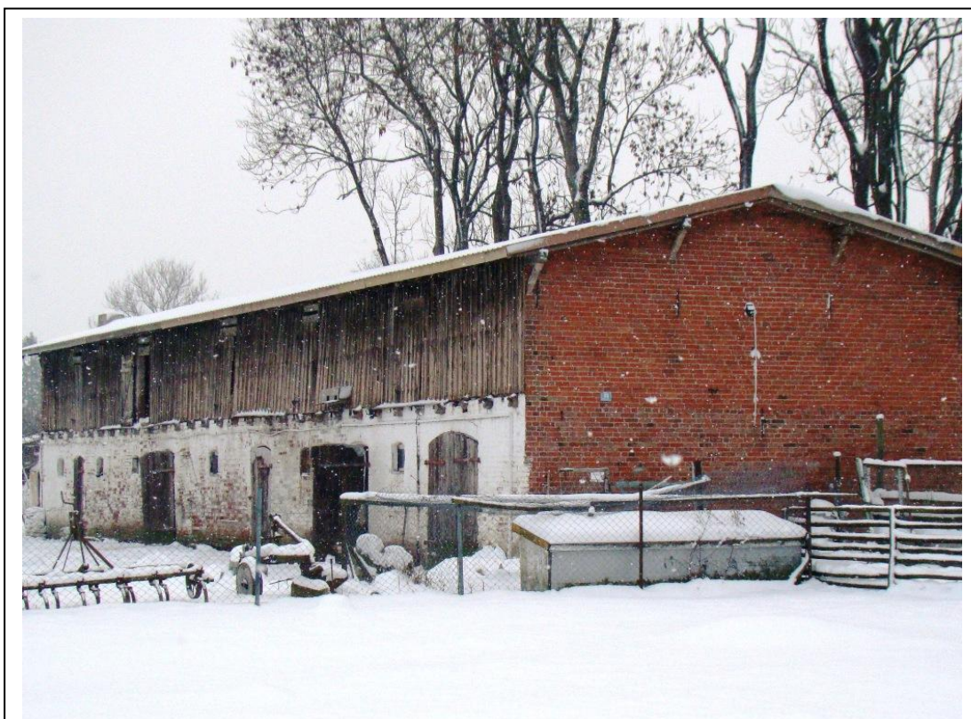
Wrzosowo 35 – budynek inwentarski – I. 10. XX w.
