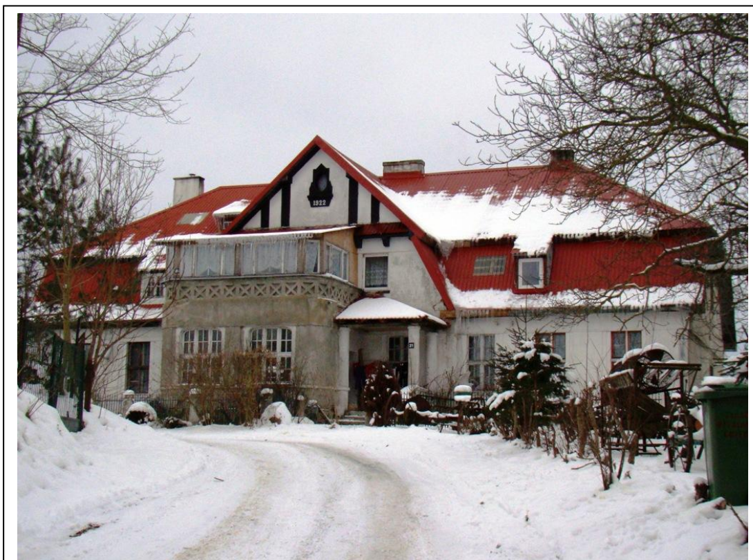
Stojkowo 30-31 - dom mieszkalny – 1922 r.
